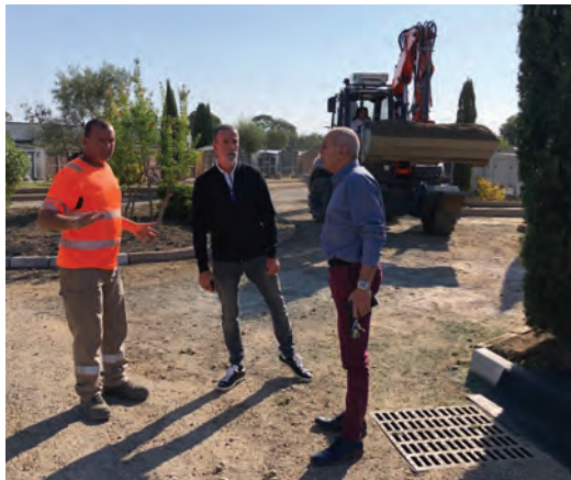
L'une des visites du chantier, effectuée début septembre par Noël Tomasi et Dumè Léoni.
