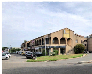
ARRET N°13 Z.COMMERCIALE DE CEPPE
