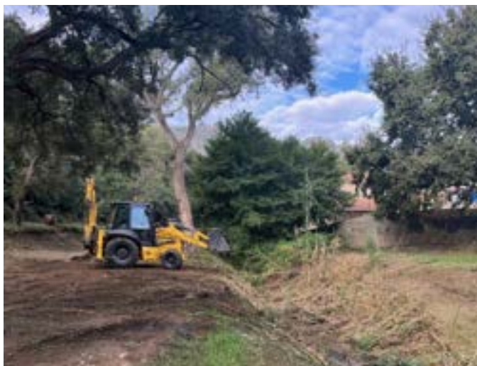
■ Nettoyage du lit du ruisseau de Ficabruna pour une meilleure évacuation des eaux de pluie.
