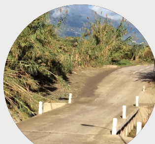
Pont du Bevincu
