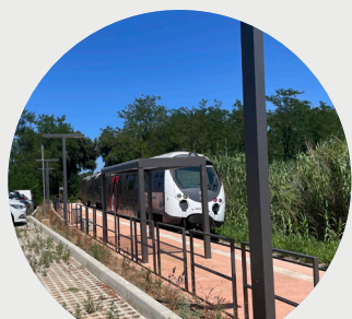
Train : Réaménagement de la halte-station de Casatorra : CFC
