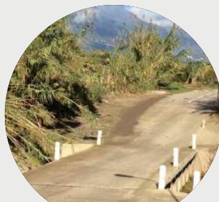
Pont du Bevincu
