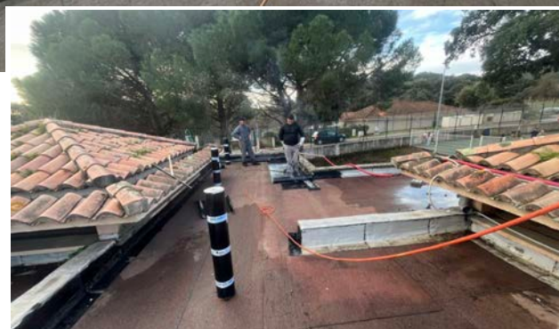
Réfection de l'étanchéité du toit des écoles Simone Peretti et Vincentello d'Istria, suite aux infiltrations constatées lors des intenses épisodes pluvieux de cet hiver.
